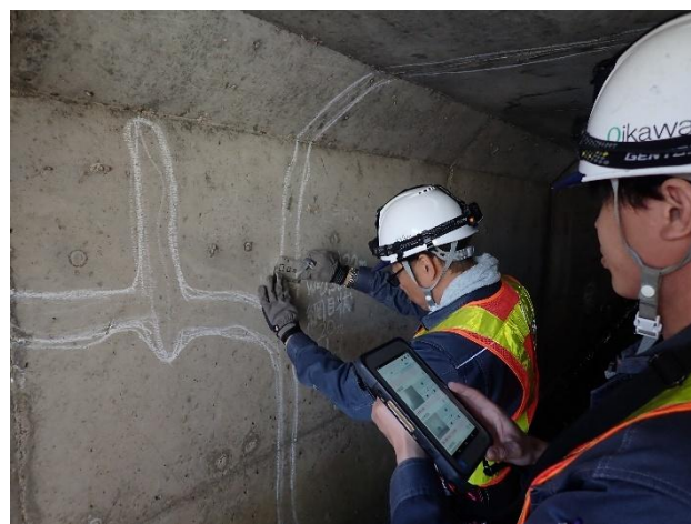
図-1 技術者による樋門函体内の目視点検
