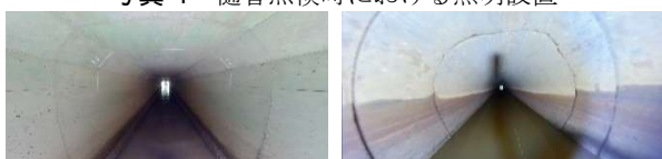
写真-5 360°カメラによる函体内部の撮影結果 (左：樋管全景 右：樋管全景)
