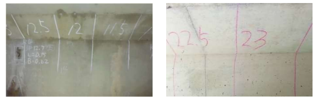
写真-2 函体内壁面におけるSP標記例
