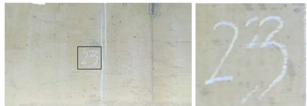
図-10 展開図の歪み（左：全体図 右：拡大図）
