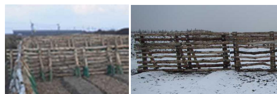
図-3 間引き材補助柵の設置状況 13) (於：浜頓別工区 左；H29設置、右；H30設置)
