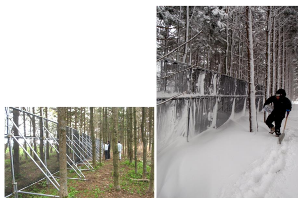
図-2 ネット柵の設置および吹雪粒子の捕捉状況 12) (於：雄信内防雪林 左；施工時、右；暴風雪時)
