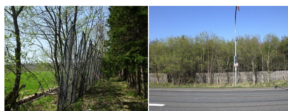
図-4 左；鋼製のネット柵（於：国府防雪林）、 右；木柵（於：猿払防雪林）
