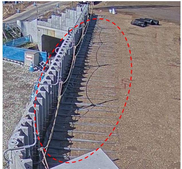
図-8 補強材の配置確認
