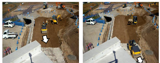
図-9 重機による転圧方向の確認
