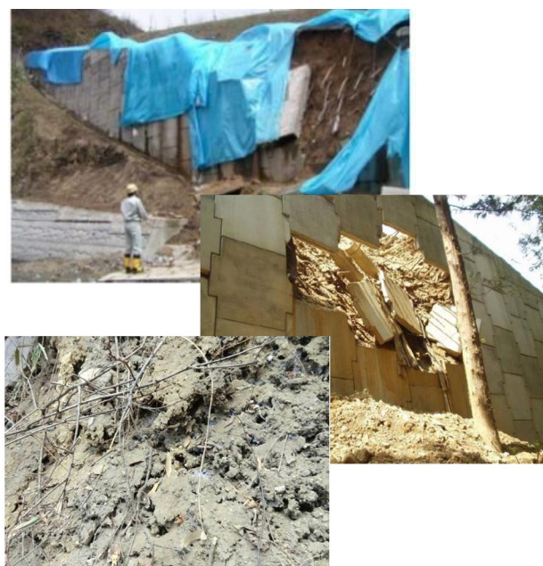
図－1 凍上により崩壊した補強土壁の変状事例
