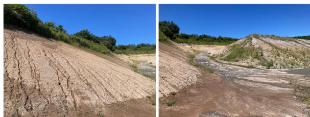
図-4 ガリ浸食を受け土砂が流出した法面
