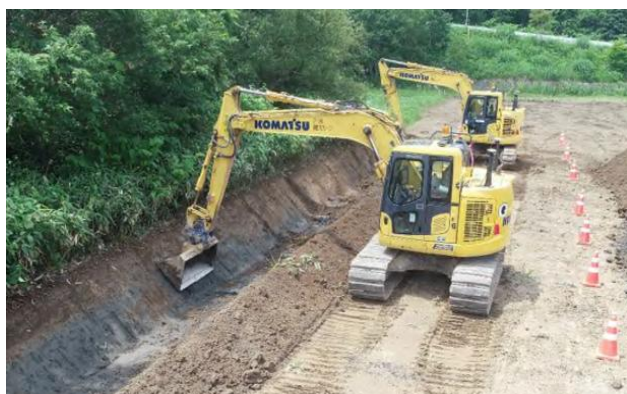
写真-3 マシンコントロールによる排水路施工
