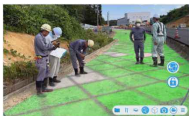
ARを活用した土工の出来形確認
