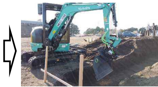
刃先が届かない細部を人力作業
