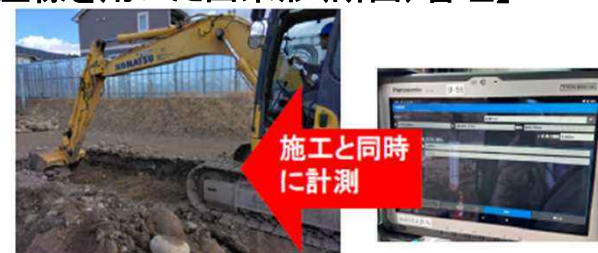
②3D-MG施工 + ②刃先による計測
