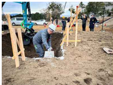
手元作業員が多い現場
