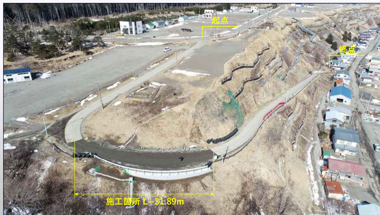
②完成写真
