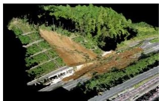
崩落後の3次元点群データ
