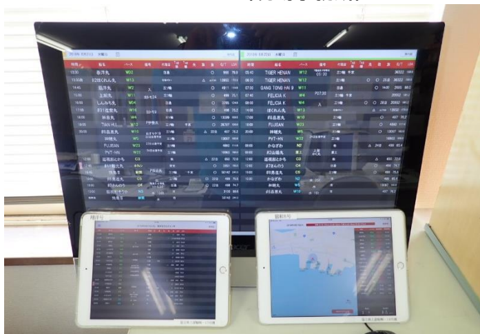
メインモニタ（現場事務所）
