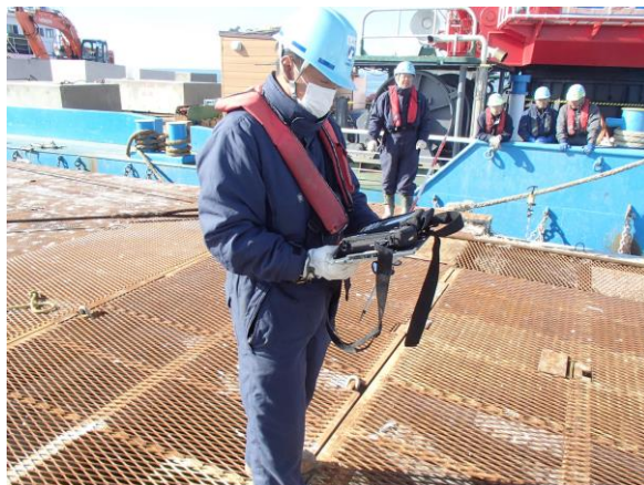
電子野帳の誘導値を確認しながら、 据付位置を調整する合図者
