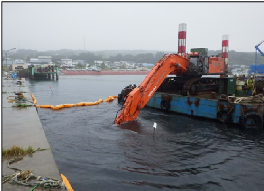
図3 GNSSによる施工状況
