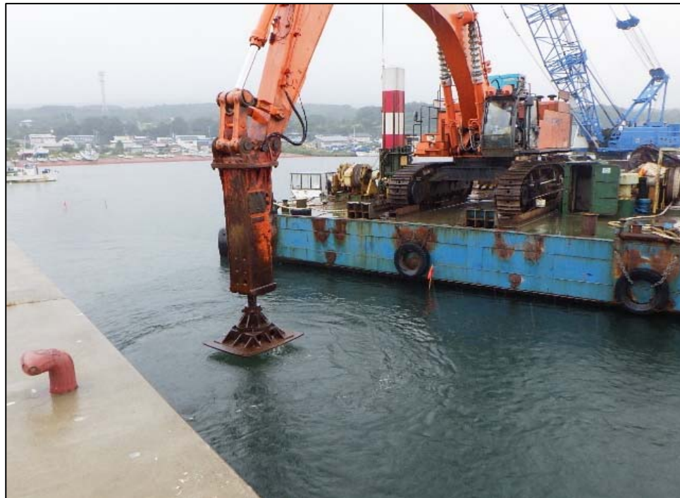
図5 既設基礎捨石天端撤去・捨石投入後、本均しタンピング状況
