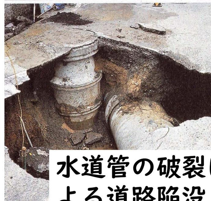
水道管の破裂による道路陥没
