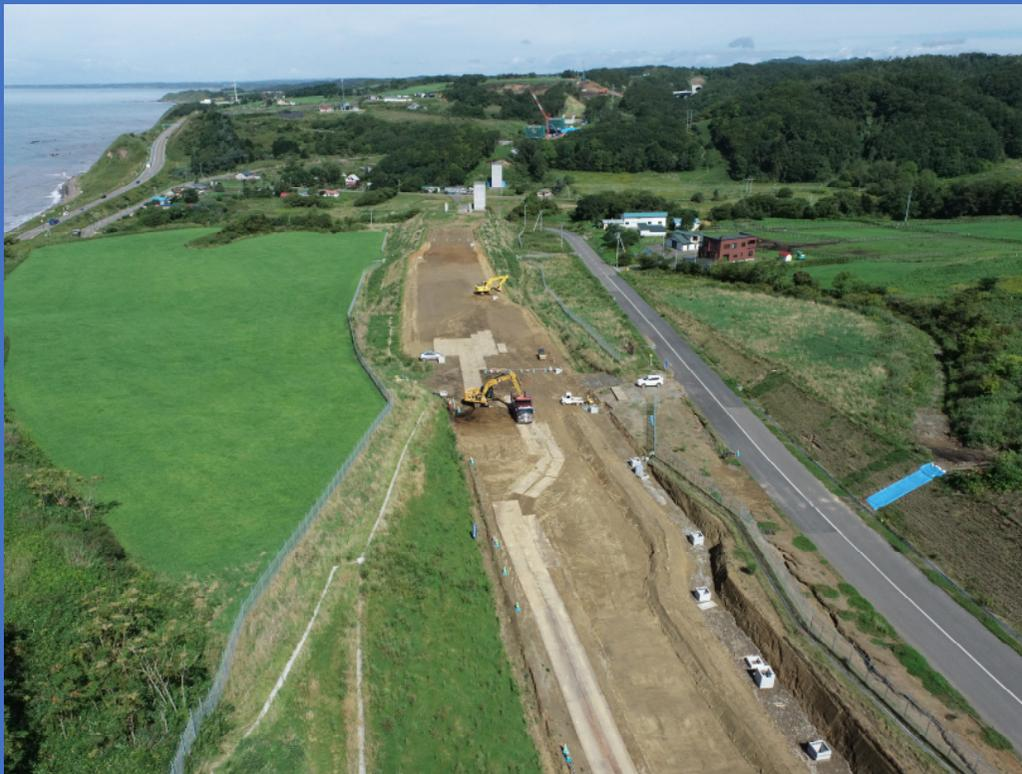
▼ 掘削・路床仕上げ状況
