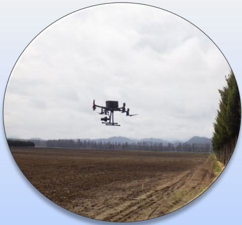
UAVを用いた 起工測量
