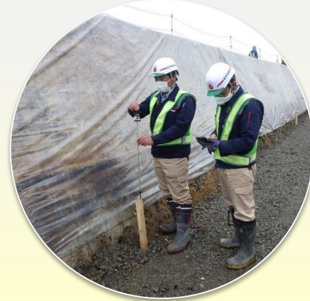
3次元計測機 出来形計測
