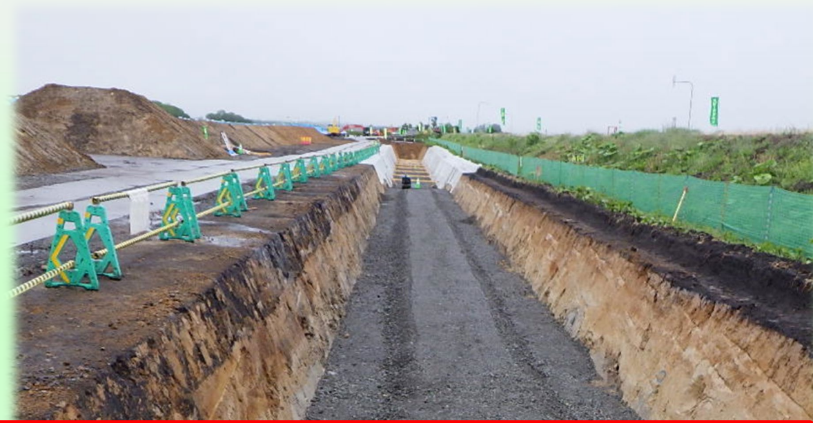
管頂30cm 埋戻砂利敷均し完了
