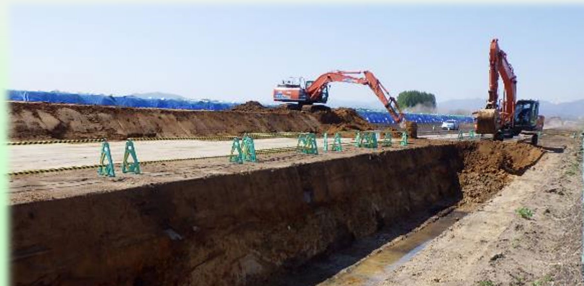
MCバックホウによる掘削状況
