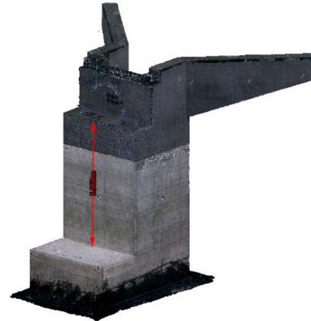
2 次施工の点群データと合成
