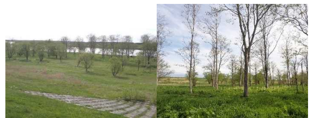
天塩川KP15.8付近左岸（表-10 No. 2）※H31伐採
