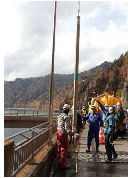
写真-5 補強鋼材挿入
