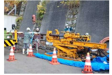
写真-6 補強鋼材接続
