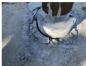
写真-3 引抜き状況
