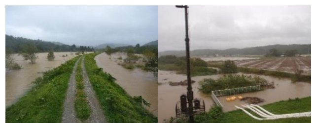
中里地区浸水状況 (KP36.4) 豊田地区浸水状況 (KP10.0)
