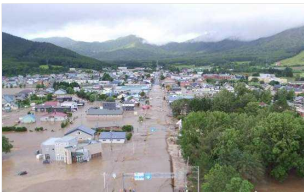
写真-1 平成28年空知川氾濫に伴う南富良野町市街地の浸水の様子（北海道開発局）
