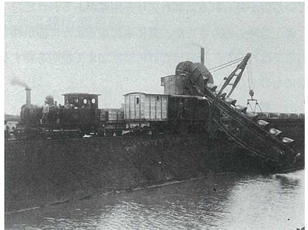
写真-3 掘削機械 エキスカベーター (大正11年)
