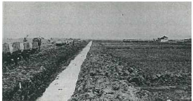
写真-2 新水路中央排水人力掘削<sup>2)</sup>
