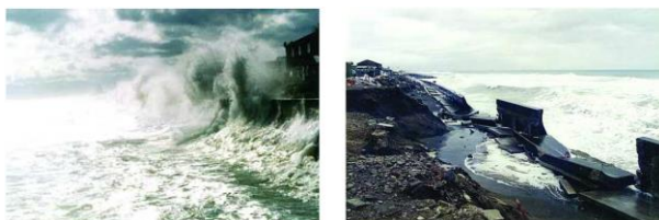
写真-2 越波状況(左)及び直立護岸被災状況(右)(平成6年)
