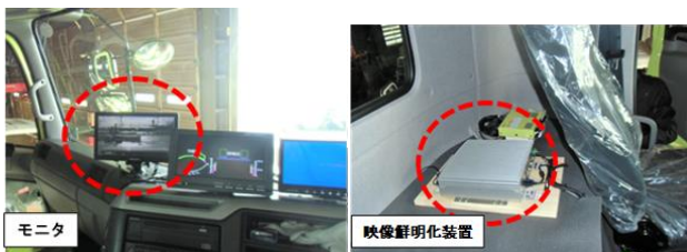
写真-5 映像鮮明化装置取付状況
