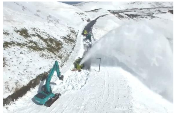
写真-2 知床峠における除雪作業
