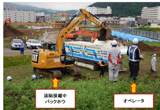
写真-13 遠隔操縦状況
