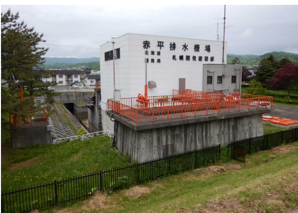
図-7 赤平排水機場全景
