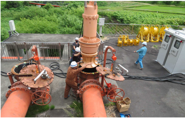
図-6 コラム形水中ポンプ挿入設置状況
