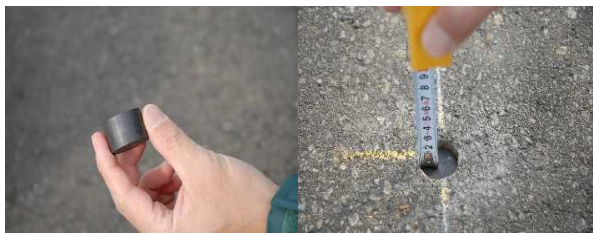
図5 磁気マーカ埋設状況
