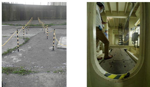
写真-3 安全対策(誘導路と狭隘な通路を明示)
