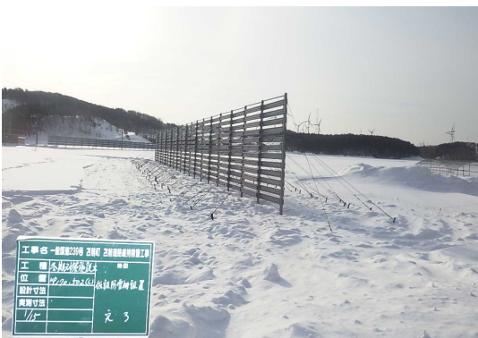
写真-3 仮設防雪柵の設置状況
