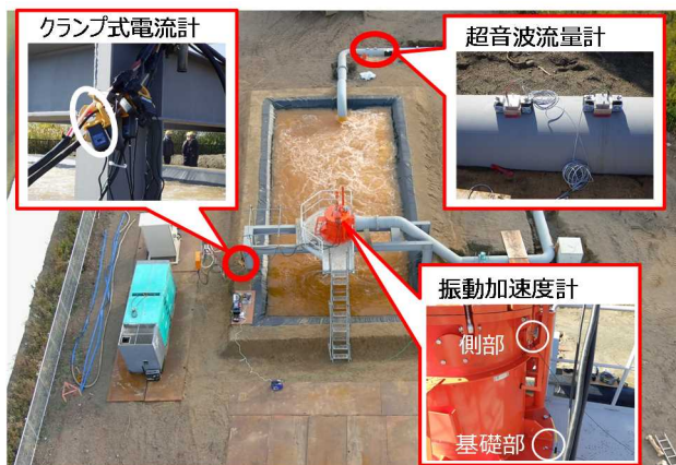
写真-4 計測機器の設置状況
