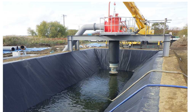
写真-2 試験用設備の仮設状況
