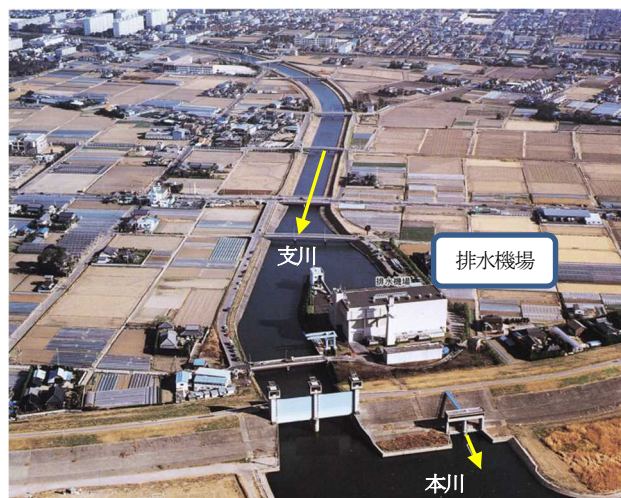
写真-1 排水機場全景
