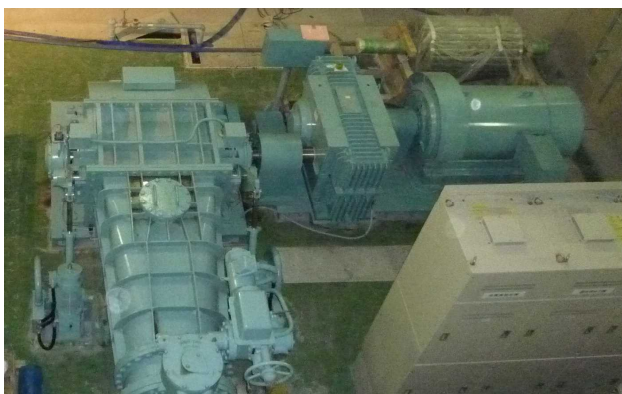
図-2 更新前クロスフロー水車
