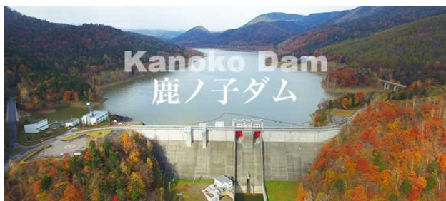
図-1 鹿ノ子ダム全景
