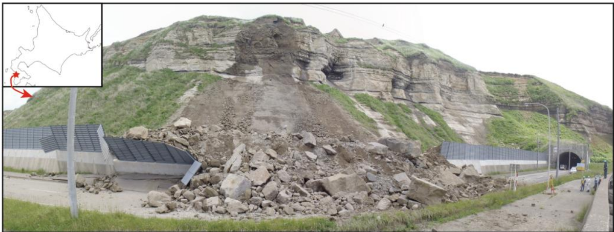
図-1：災害斜面のパノラマ写真(2021年6月7日撮影 函館開発建設部提供)
