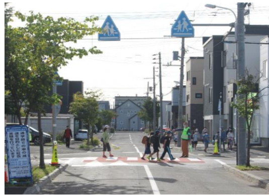
写真-2 スムーズ横断歩道設置状況（札幌市手稲区西宮の沢）
