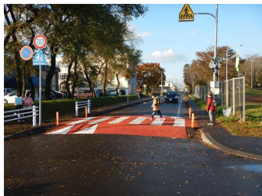
写真-3 スムーズ横断歩道設置状況（苫小牧市澄川町）
