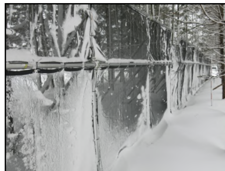
写真-10 雪粒子が捕捉された状況
