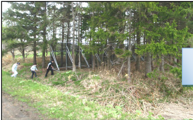
写真-7 雄信内防雪林内への設置が完了した防風ネット柵 (左写真：林帯中央部への設置状況、右写真：柵に近接し撮影)
