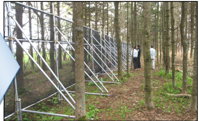
写真-7 雄信内防雪林内への設置が完了した防風ネット柵 (左写真：林帯中央部への設置状況、右写真：柵に近接し撮影)
