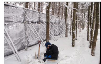
写真-16 柵の国道側に着雪した事例
