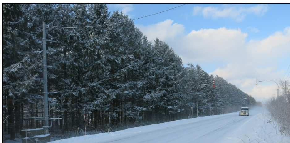
写真-1 雄信内防雪林の全景と計測機器設置状況(写真左側電柱に風速計などを設置:令和3年1月撮影)
