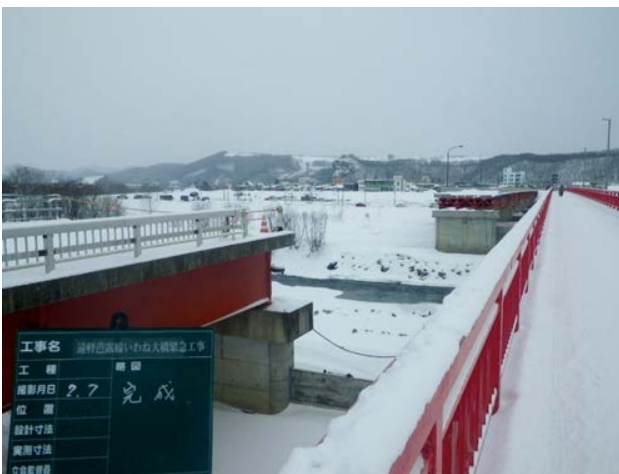
写真-3 応急復旧工事完成
