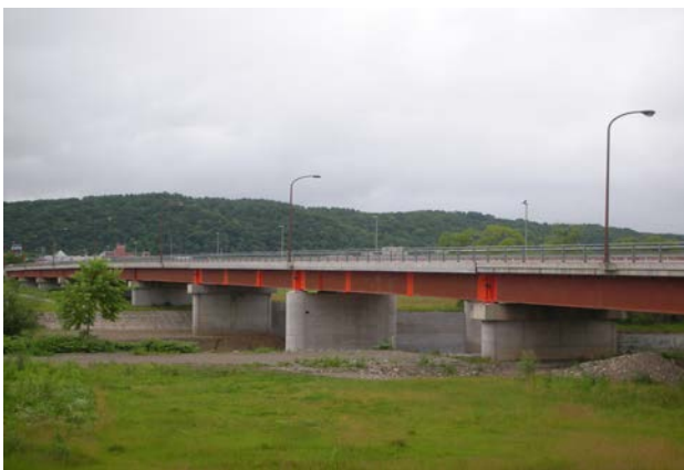
写真-6 いわね大橋復旧工事完成
