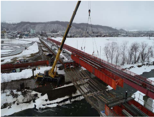
写真-5 上部工復旧工事施工状況
