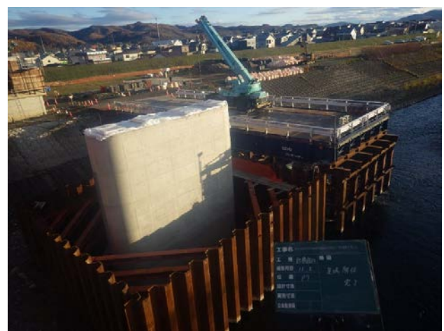
写真-4 下部工復旧工事施工状況
