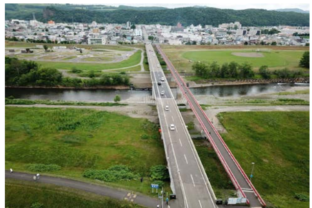
写真-8 いわね大橋復旧後の状況
