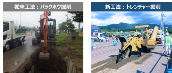
写真-9 国道5号赤松街道電線共同溝での掘削状況
