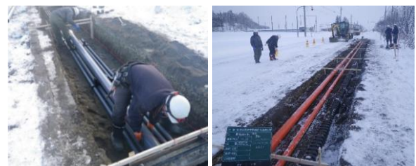
写真-6 浅層埋設の試験施工（美深町）
