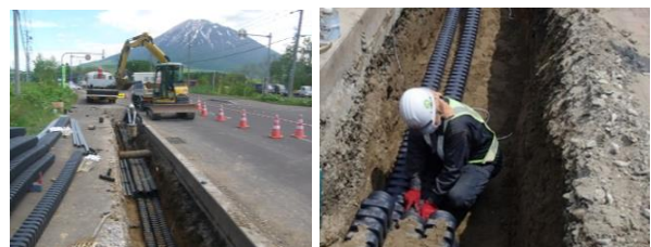
写真-7 角型多条電線管の試行導入（倶知安町）
