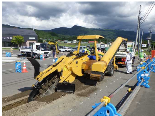
写真-4 トレンチャーによる施工状況
