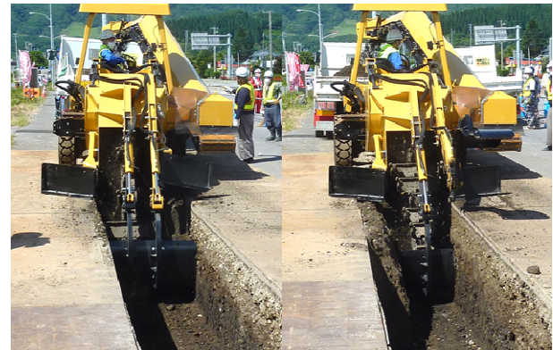
写真-7 トレンチャーでの掘削状況 (左:2回目, 右:1回目)
