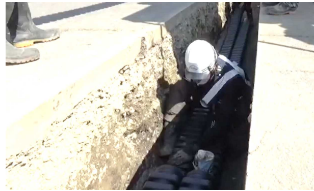
写真-6 配管敷設状況
