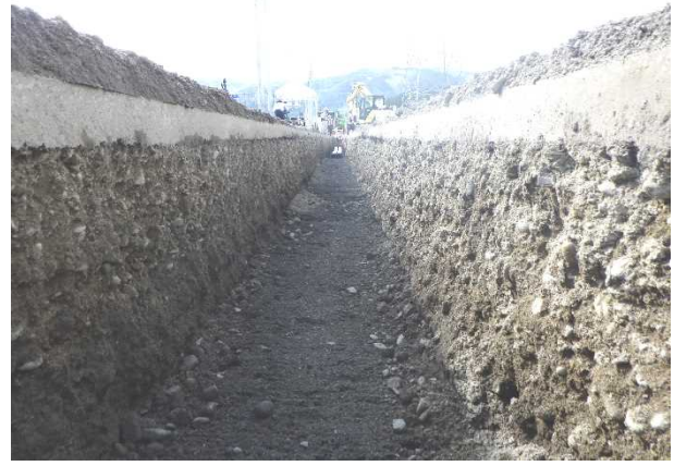
写真-5 掘削後の仕上がり
