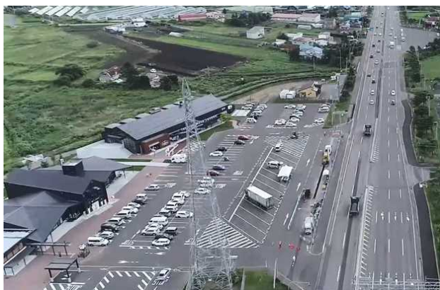
写真-1 試験施工箇所
