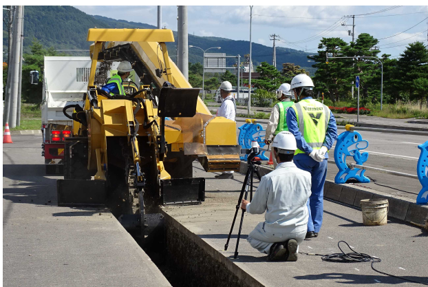
写真4 トレンチャーによる試験風景
