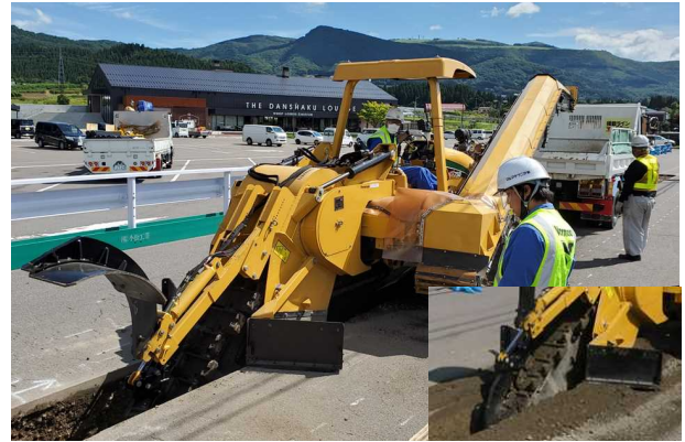
写真-2 トレンチャー掘削機
