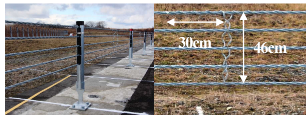
写真-12 防護柵設置状況とロープ連結材取付状況
