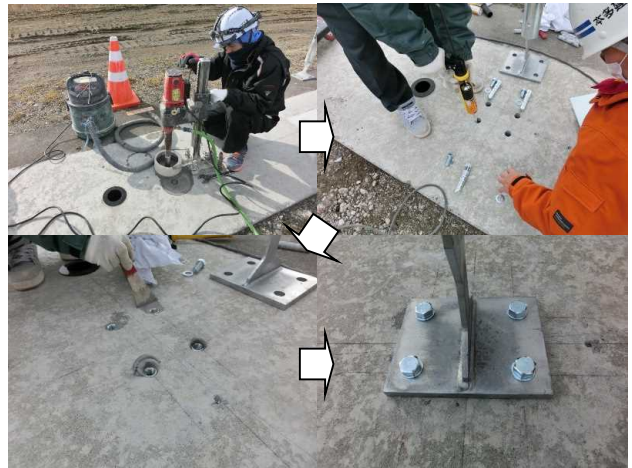
写真-8 接着系めねじタイプ施工状況
