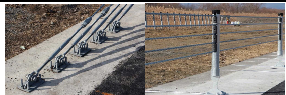
写真-9 設置状況(左:端末金具、右:既設橋梁用支柱)
