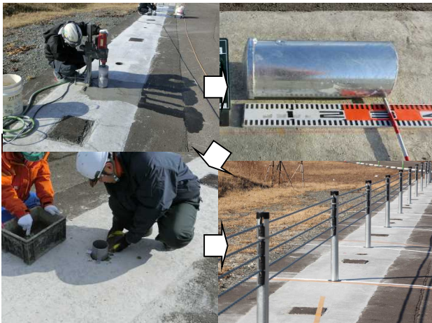
写真-4 ワイヤロープ式防護柵施工状況
