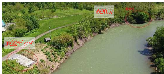
写真3 展望デッキ整備状況
