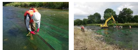
写真-4 工事前の環境保全対策 (産卵防止ネット敷設状況)
