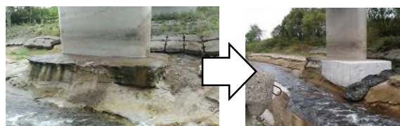
写真-6 北見市管理の橋梁の応急対策
