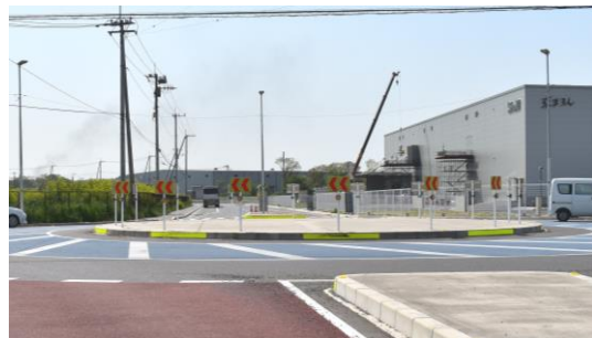
写真-2 対面見通しを制御していない国内事例
