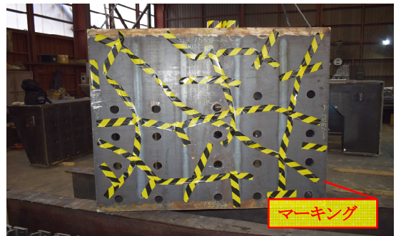
写真-4 アンカー位置に合わせて製作されたブラケット
