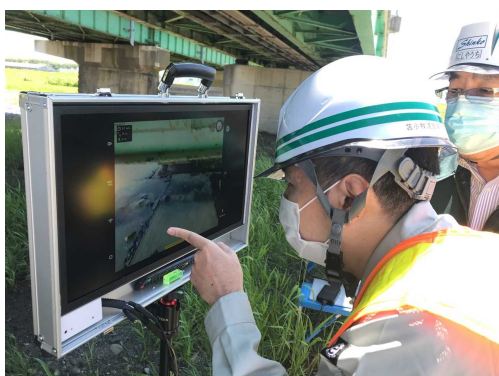
写真-3 小型特殊UAVの撮影画像の確認 (4Kビデオカメラ)
