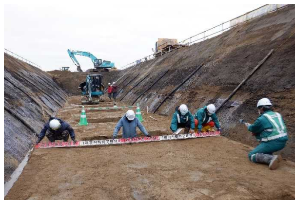
写真-3 遠隔臨場の実施状況（受注者）
