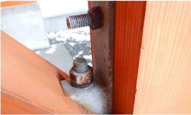
写真-4 外部金物の錆の様子(宗谷管理署 自転車置場)
