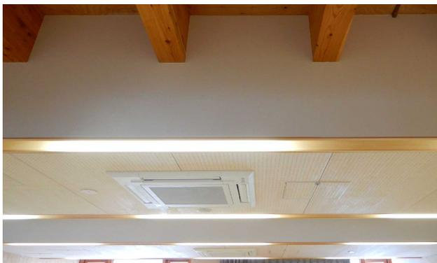
写真-7 下がり天井室内空調機設置例(某施設)
