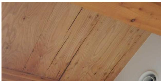
写真-1 木材のひび割れの様子
