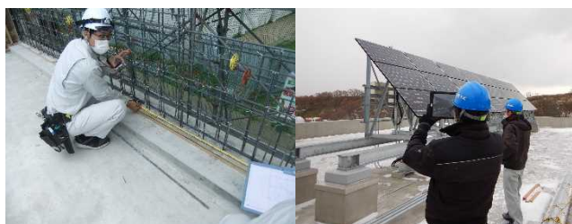
図-5 工事受注者の遠隔臨場の対応
