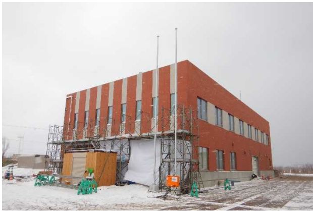
図-2 庁舎外観（令和3年12月現在）
