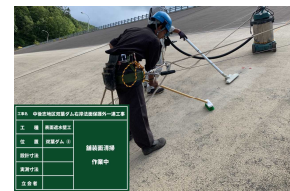
写真-6 清掃 (ひび割れ内部)
