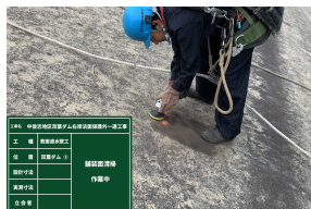
写真-7 清掃 (施工面)
