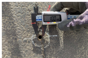
写真-5 施工部処理 (削孔)
