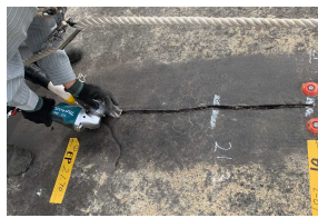
写真-3 施工部処理 (Uカット)
