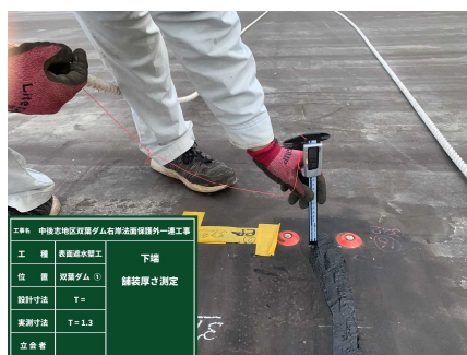
写真-11 施工厚さ t=1.3\text{mm} (RC加熱シーラ)
