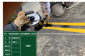
写真-8 注入 (RC加熱シーラ)
