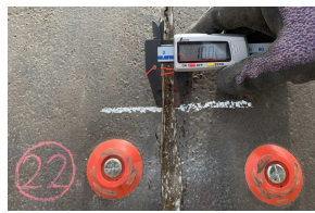
写真-4 施工部処理 (Uカット)
