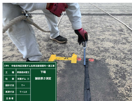
写真-12 施工厚さ t=1.0\text{mm} (クイックスティック)
