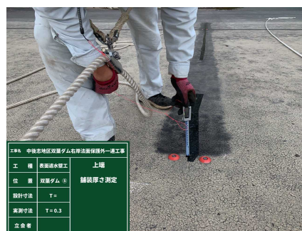
写真-14 施工厚さ t=0.3\text{mm} (RC常温メンテ)
