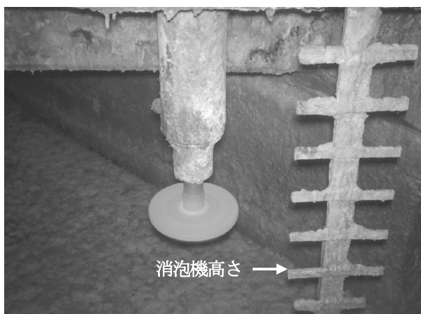
写真5 調整槽内の泡（2021年8月1日 14時14分）
