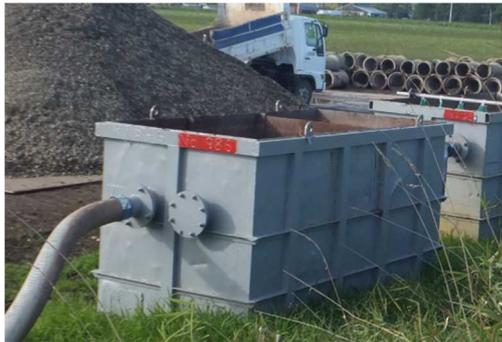
写真-10 濁水処理用の鋼製水槽
