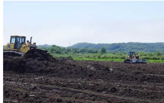
写真-6 ブルドーザーによる整地作業
