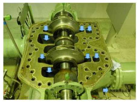
写真-3 内部カメラ挿入箇所（安平揚水機場）
