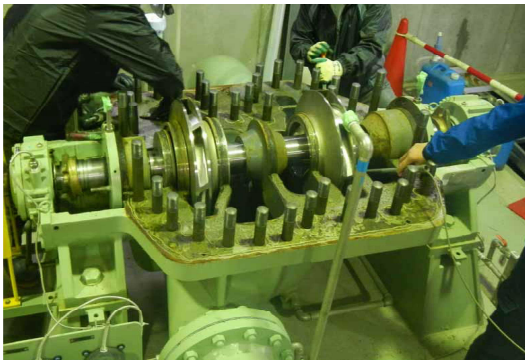
写真-6 内視鏡による調査状況（安平揚水機場）
