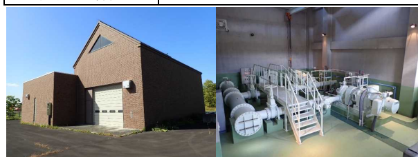
写真-2 瑞穂揚水機場の状況
