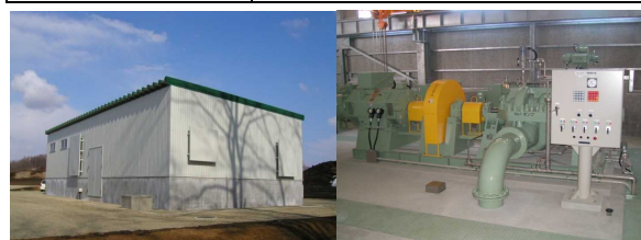
写真-1 安平揚水機場の状況
