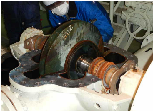
写真-7 目視による調査状況（瑞穂揚水機場）
