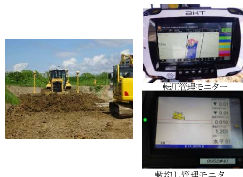
写真-4 ICT ブルドーザー稼働状況
