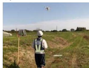
写真-1 ドローンによる起工測量
