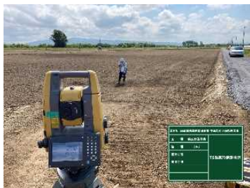
写真-7 TS 出来型計測機器による確認
