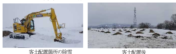
写真-6 冬客土の施工状況
